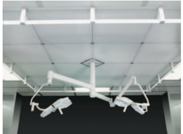
Zuluft-Decke für Operationsräume
