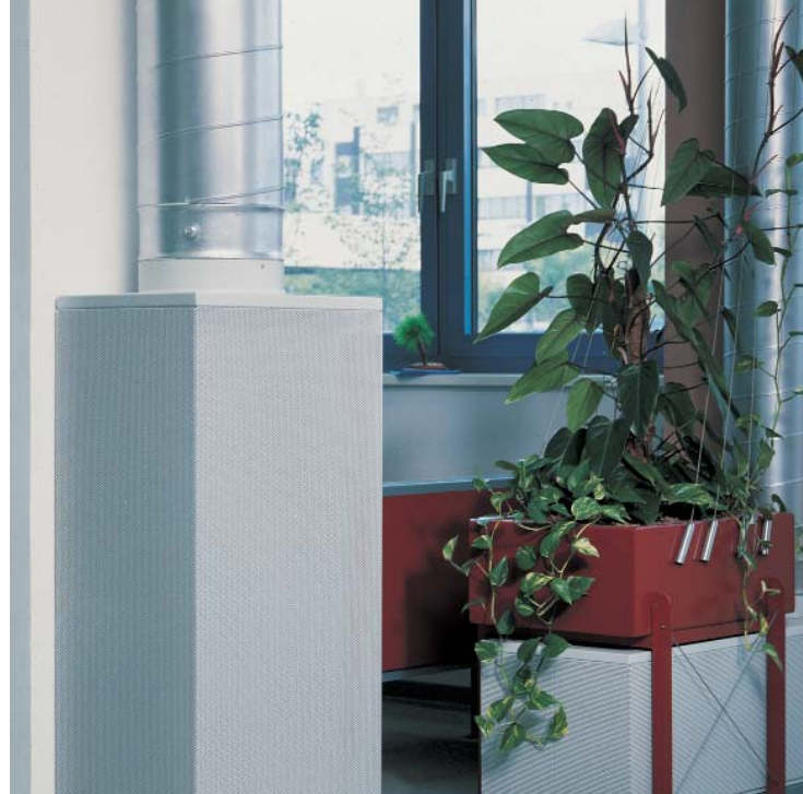
Rectangular displacement outlet, type Q-R, in the canteen of the publishing house 'Mitteldeutsches Druck- und Verlagshaus' at Halle / D
